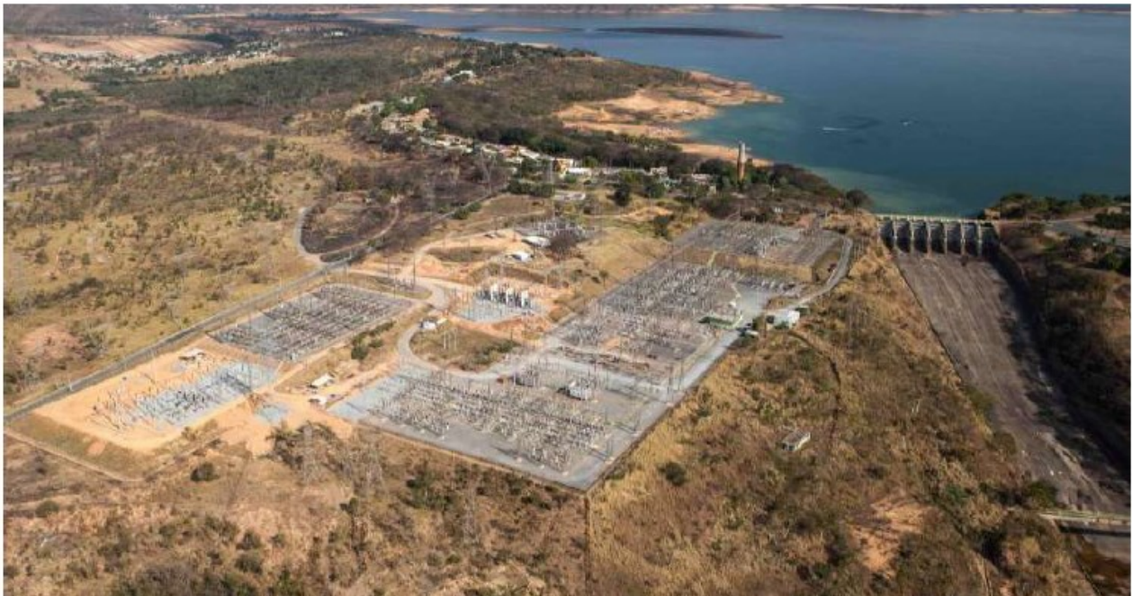
Figura 1-1 – Visão geral da usina e da SE 345/289/138/13,8 kV Três Marias
